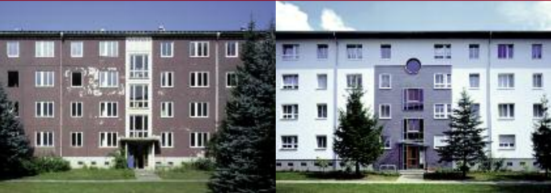
Nouveau souffle de vie : isolation contemporaine et valorisation architecturale d'une barre de lotissement à Cottbus
