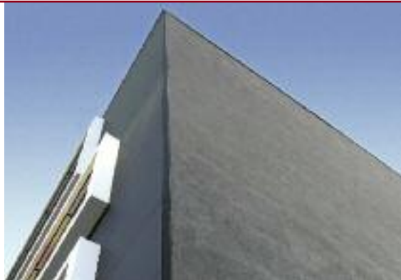
Enduit et pierre naturelle – une harmonie parfaite de tons noirs : immeuble d'habitation et de bureaux dans le quartier de Falkenried à Hambourg
