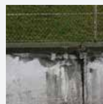
Eclats de béton ou d'enduit
